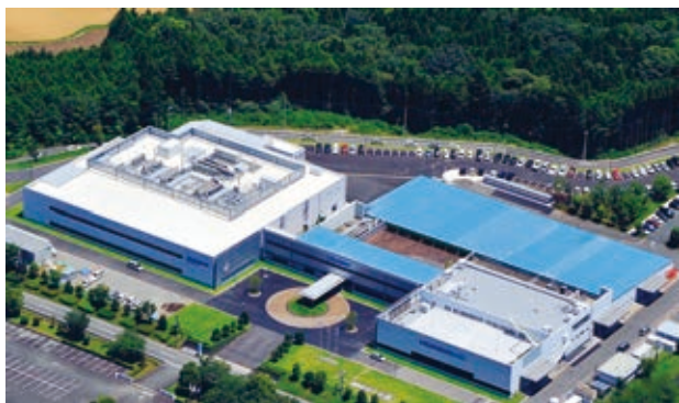
堀場エステック阿蘇工場
