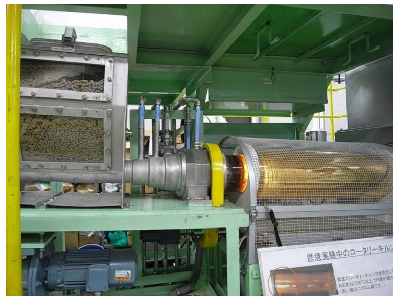
投入口と一次燃焼炉
