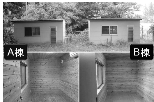
図9 実験棟の外観および内装
